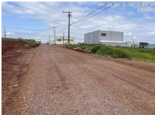
Foto 1: Rua sem pavimentação frente terreno Fonte: Autora
