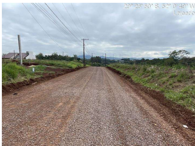
Foto 1: Rua sem pavimentação frente terreno Fonte: Autora
